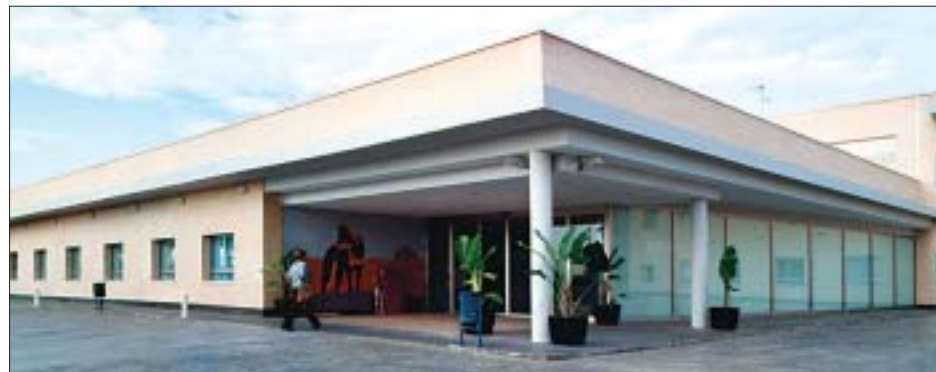
Fachada de la nueva residencia Cantallops. A la derecha, el pórtico que hay en el exterior del edificio.
